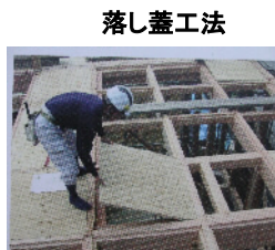
落とし蓋工法
