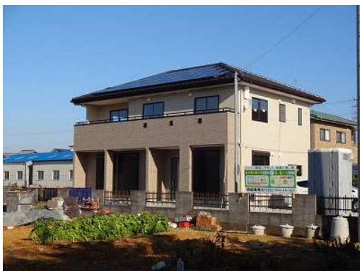
落ち着いたある奇棟の屋根 (太陽光発電システム搭載)
